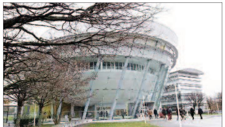
3 500 salariés côtoient 1 000 chercheurs – à proximité d'un campus qui accueille 3 500 étudiants – sur un site qui s'étend sur quelque 170 hectares. Photo Jean-Marc Loos
